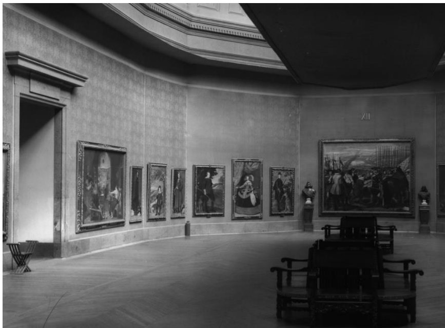
Imagen 3. Fotografía hacia 1950 donde se observa Las Hilanderas a la izquierda, con la ampliación
