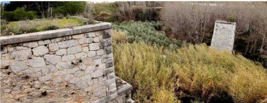
Ilustración 2. Imágenes actuales de la zona de construcción de la pasarela. (Fuente: información proporcionada por el tutor).
