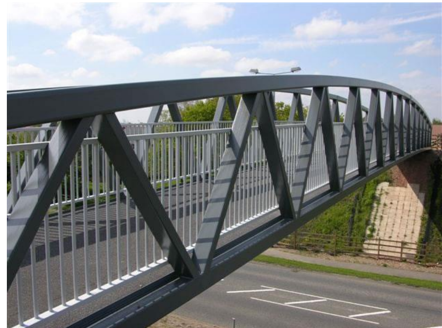
Ilustración 3. Pasarela celosía tipo Warren actual. (Fuente: Ingeniería y Construcción MIC SAS Bogotá).
