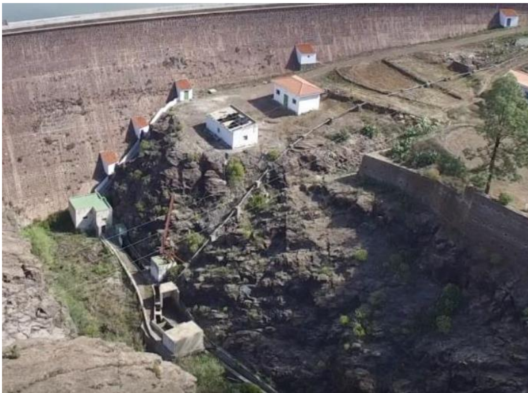
Figura 6. Vista desde aguas abajo de las tomas de la presa de Chira.
