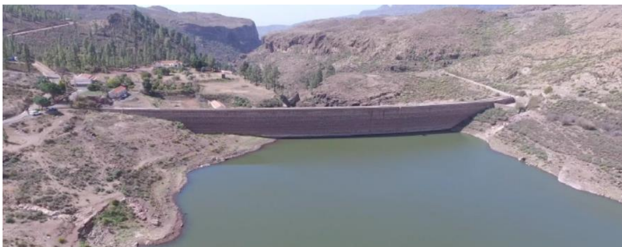
Figura 4. Vista desde aguas arriba de la presa de Chira.
