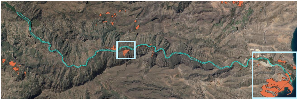
Figura 24. Referencia imágenes google earth, formación de brecha en 15 minutos y sin avenida.
