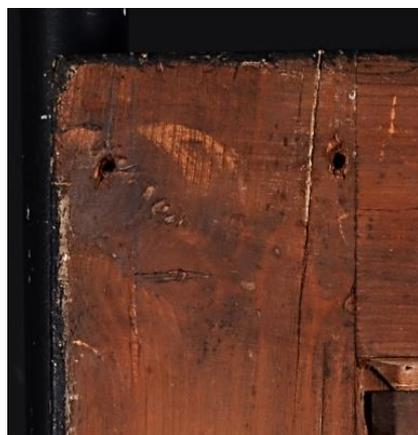
Imagen 34. Detalle del reverso del marco donde se muestran unas perforaciones.
