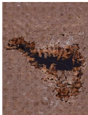
Fig.34 Detalle faltante con desgarro.
