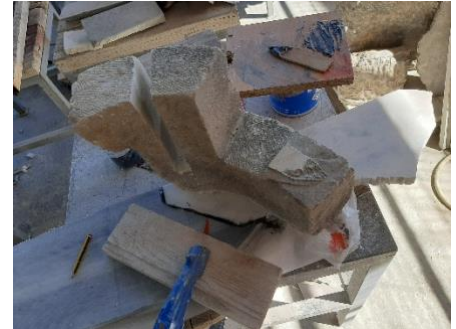
Figura 41: Hendidura practicada en la arenisca. Foto del autor.
