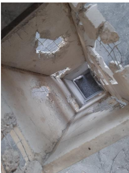
Figura 58: detalle del interior de la estructura del hormigón. Foto del autor.
