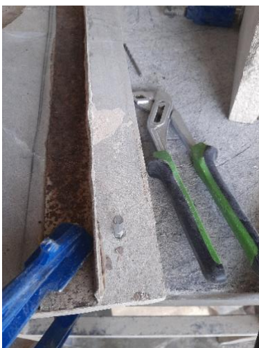
Figura 43: Detalle de la colocación del perno. Foto del autor.
