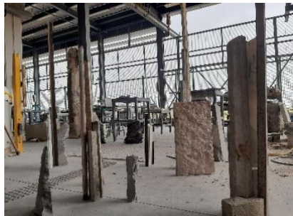
Figura 5: Primera instalación de los trabajos en la zona de trabajo. Foto del autor.
