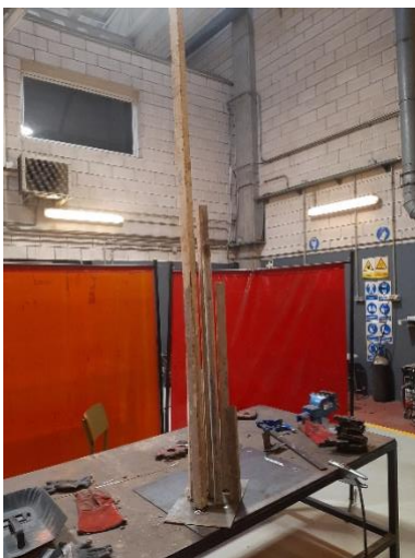
Figura 51: Soldadura de los perfiles de hierro. Foto del autor.
