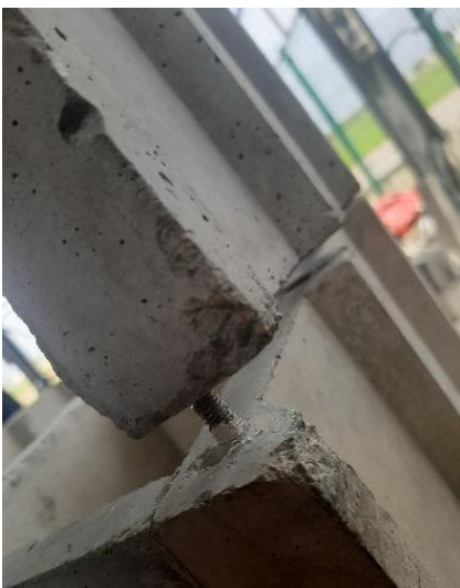
Figura 55: Unión mediante pernos. Foto del autor.
