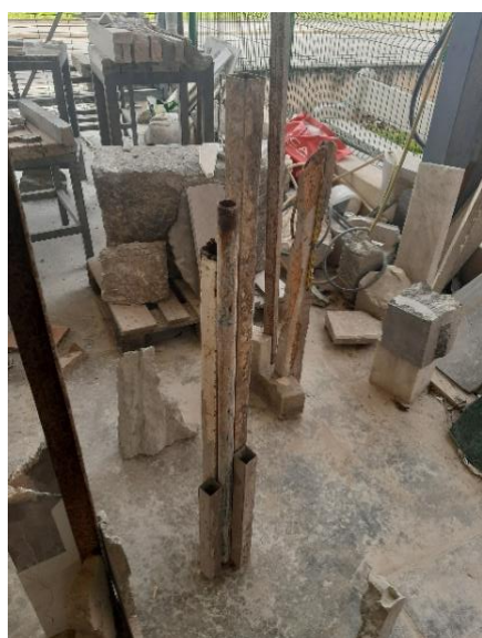
Figura 36: perfiles recuperados oxidados. Foto del autor.
