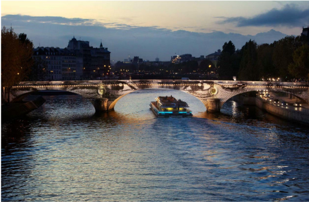
ILUSTRACIÓN 19. INTERVENCIÓN EN PUENTES DEL RÍO SENA POR JR [42]
