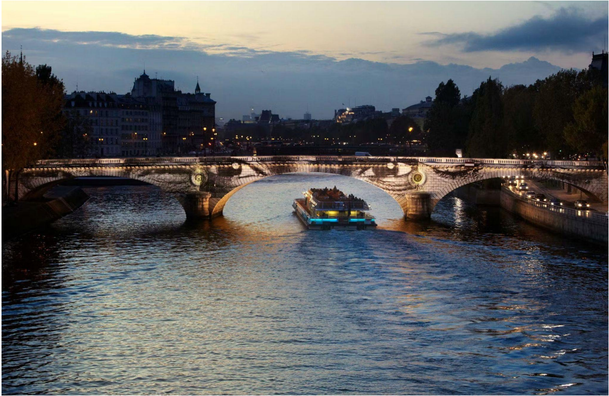
ILUSTRACIÓN 19. INTERVENCIÓN EN PUENTES DEL RÍO SENA POR JR [42]
