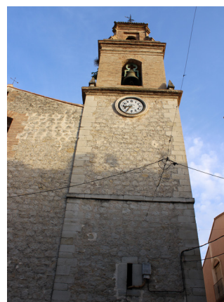
Imatge 3. Torre de campanes de l'Església.
