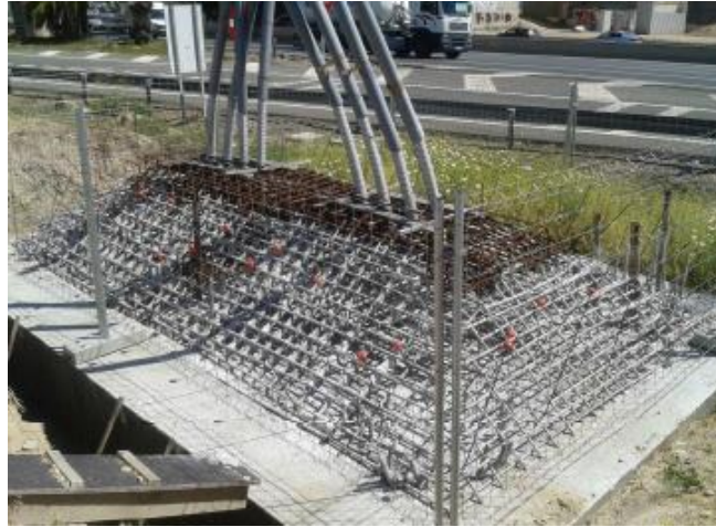
Ilustración 2- Encepado de la Pila 1, lado de San Juan
