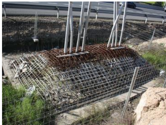
Ilustración 4- Encepado de la Pila 2, lado de Sevilla
