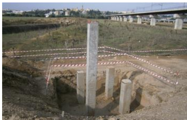
Ilustración 1- Pilotes de la Pila 1, lado de San Juan
