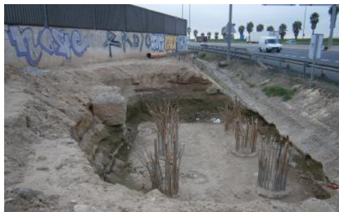
Ilustración 3- Pilotes de la Pila 2, lado de Sevilla
