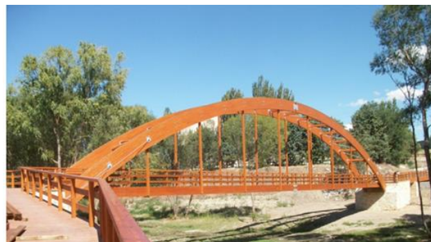
Ilustración 4- Pasarela sobre el río Adaja en Ávila
