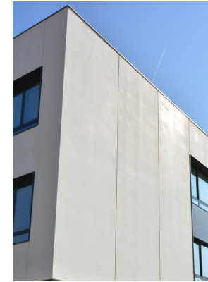
Fachada paneles sándwich GRC
