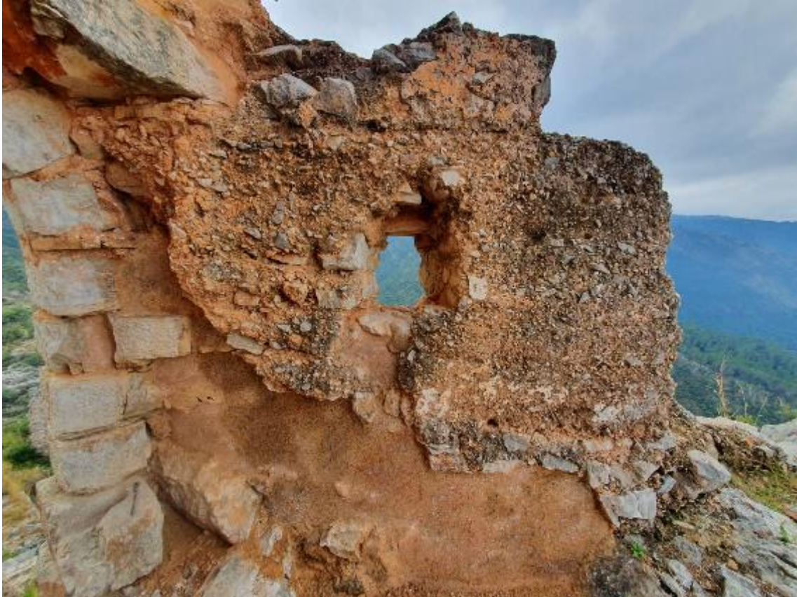
Torre de l’Homenatge. Vista sud. Puerta de medio punto. Después de la restauración. Sellado del faltante en contacto con el suelo y de todos los demás con mortero. Fuente: BALLESTEROS, 2022.
