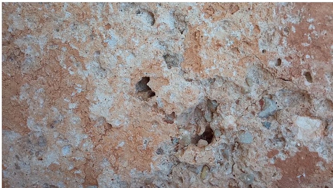
Figura. 30. revestimiento del paramento Norte interior de la Torre. Pérdida del material en superficie. Fuente: CASTELLET, 2021.
