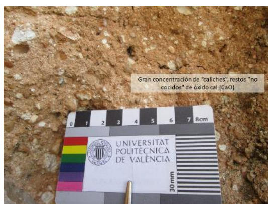
Figura. 17. Gran concentración de caliches en muro Este de la Torre. Fuente: ZALBIDEA, 2021.
