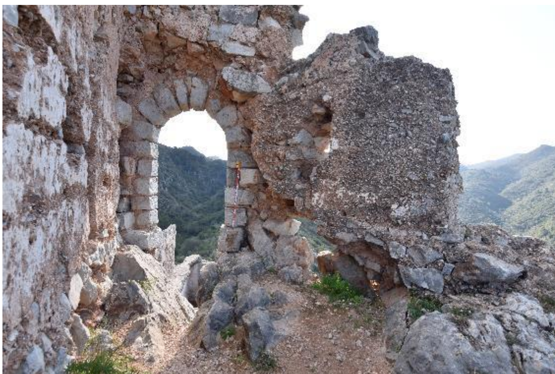
Torre de l’Homenatge. Vista este. Puerta de medio punto. Antes de la restauración. Fuente: ZALBIDEA, 2021.
