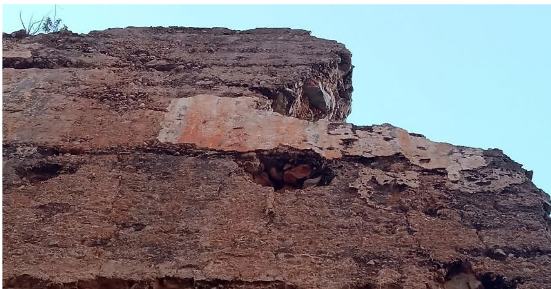
Figura. 11. Muro de construcción a tapial situado en frente de la capilla cristiana. Aún conserva revestimiento en zonas concretas. Se observan los agujeros por aguja de tapial. Fuente: CASTELLET, 20220.
