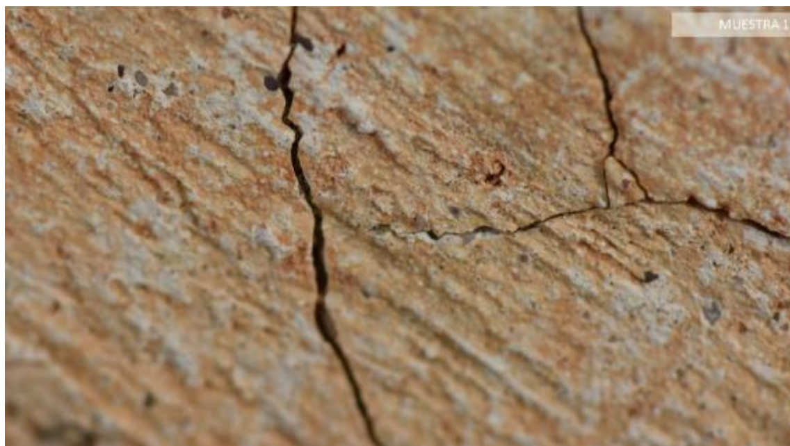
Muestra 1. Imagen de detalle del anverso del mortero. Pátina rojiza del estuco y en la que aún se observan la huella generada por la herramienta al aplicar el estrato. Fuente: CASTELLET, 2021.
