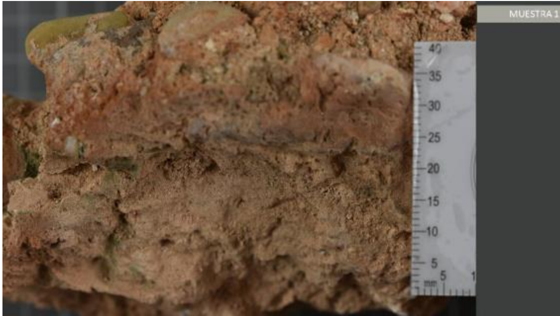
Muestra 1. Reverso del mortero de tonalidad rojiza en la que se aprecia una acumulación en el guarnecido de áridos de partículas superiores en zona de más próxima al enlucido. Fuente: CASTELLET, 2021.
