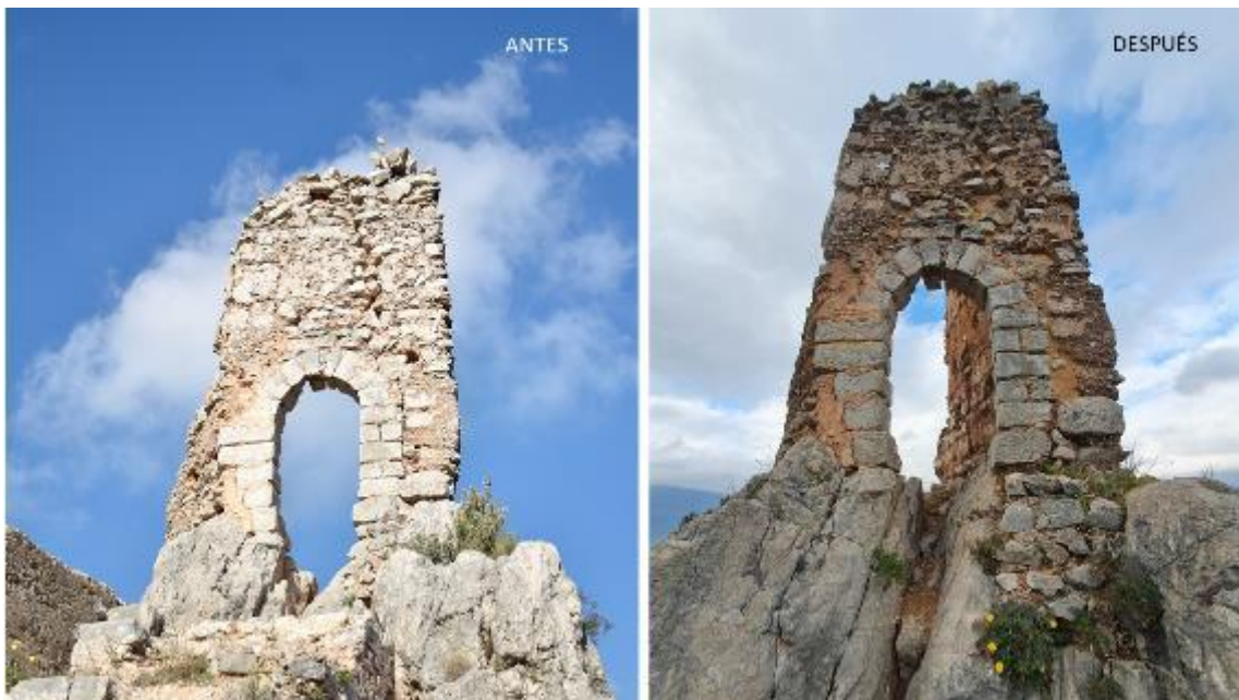
Muro este exterior y la puerta de medio punto de la Torre de l’Homenatge. Izqda.: Antes de la restauración. Fuente: ZALBIDEA, 2021; Drcha.: Después de la restauración. Fuente: BALLESTEROS, 2022.
