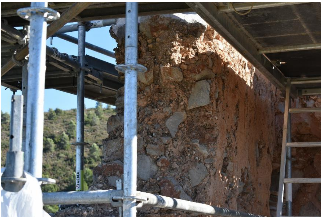
Figura. 21. Muro este norte interior. Se aprecia el grosor del mismo. Fuente: ZALBIDEA, 2021.
