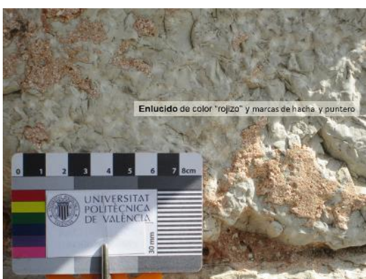
Figura. 16. Marcas del hacha y restos de enlucido rojizo debajo del arco de medio punto de la Torre. Fuente: ZALBIDEA, 2021.
