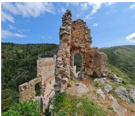
Figura. 14. Vista este de la Torrassa. Se aprecian los numerosos faltantes y la falta de pavimento. Fuente: Izqda. VALENCIABONITA®, 2021; Drcha.: ZALBIDEA, 2021.
