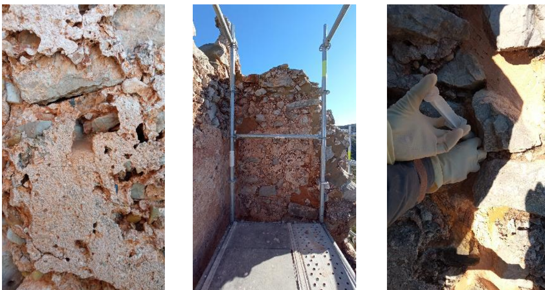
Figura. 34. De izqda. a drcha.: Aplicación de mortero en zonas donde se deposita el agua de lluvia; Mortero aplicado en sellado muro Este interior; Consolidación por colada/ inyección de cal hidráulica NHL-5 (lechada). Fuente: CASTELLET, 2021.
