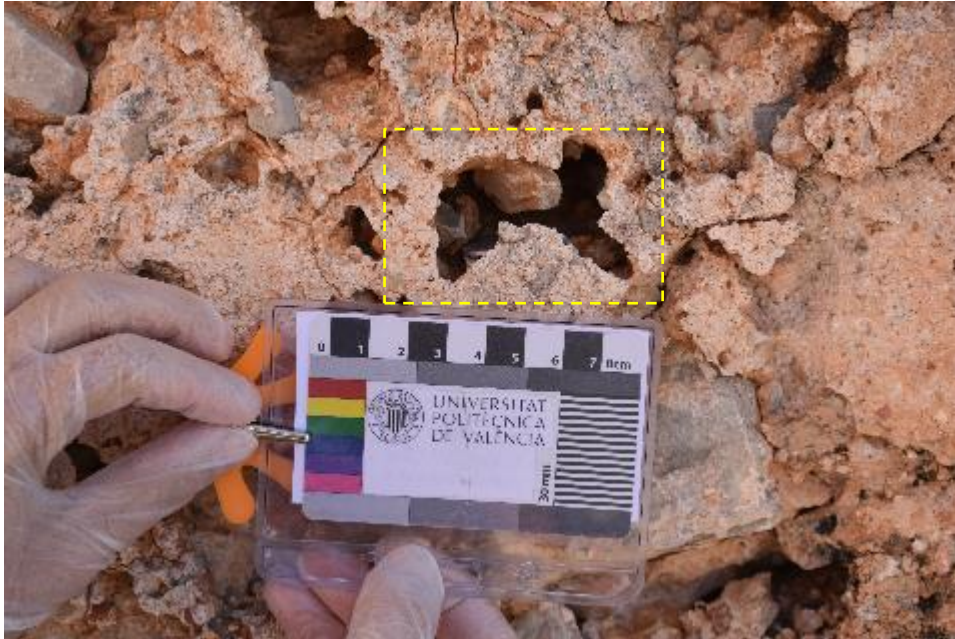
Muestra Moneda. Localización en muro este interior superior, dentro de una oquedad del revestimiento de la Torre de l’Homenatge. Fuente: ZALBIDEA, 2021.
