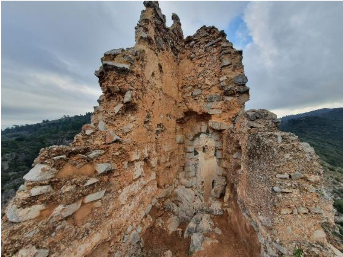
La Torre de l’Homenatge tras la restauración. Fuente: BALLESTEROS, 2022.
