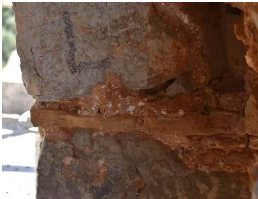
Figura. 19. Zona del arco de medio punto. Se aprecian caílches entre mortero de color rojizo. Sobre piedra caliza, se observa un grafismo por acto vandálico. Fuente: ZALBIDEA, 2021.
