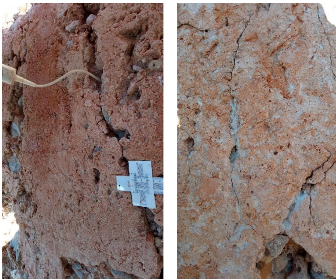
Figura. 31. Aplicación de lechada de cal hidráulica como método de consolidación y rejunte de fisuras y oquedades (drcha.). Tras inyección (izqda.). Fuente: CASTELLET, 2021.
