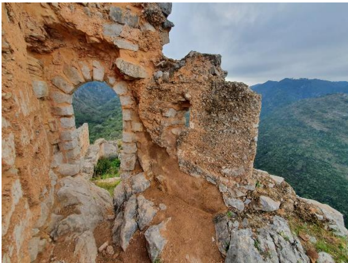
Figura. 35. Imagen sup.: Torre de l’Homenatge. Vista este. Puerta de medio punto. Antes de la restauración. Fuente: ZALBIDEA, 2021. Imagen inf.: Restauración de la Torre. Fuente: BALLESTEROS, 2022.
