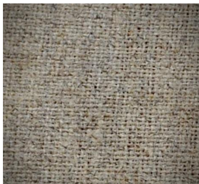
Imagen 37. Soporte de entelado total de la obra.
