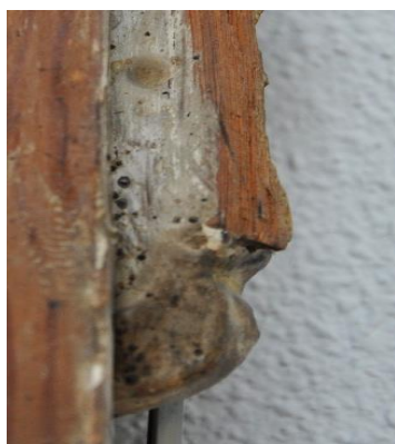
Imagen 71. Detalle de los orificios producidos por ataque xilófago.
