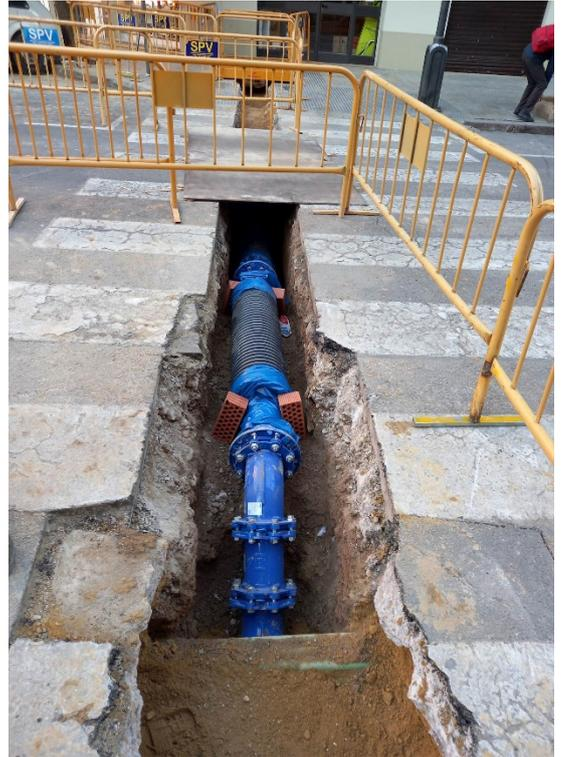
Ilustración 27: Tubería de protección para cruce
