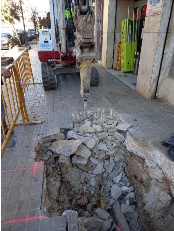
*Ilustración 20: Demolición de acera*
