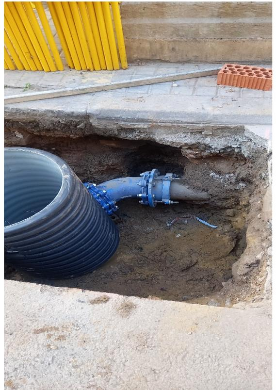
Ilustración 29: Conexión a pozo
