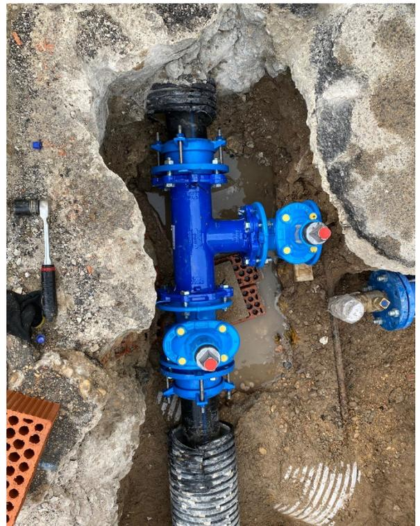
Ilustración 25: Montaje tee con válvulas
