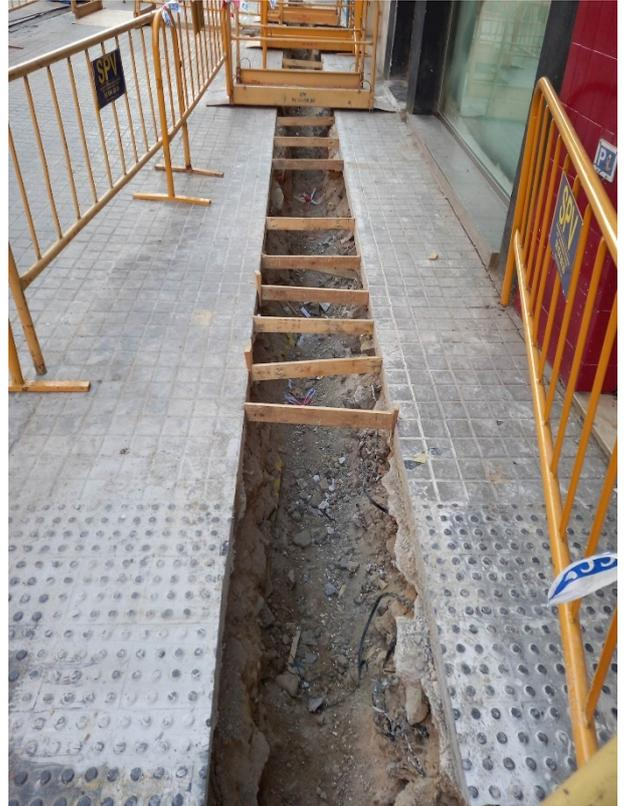
*Ilustración 21: Apertura de zanja*
