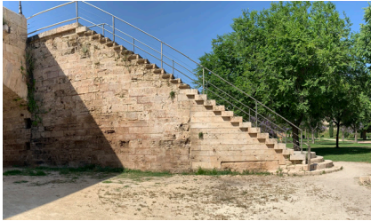
Figura 20.- Escalera del Puente de la Trinidad (actualidad)
