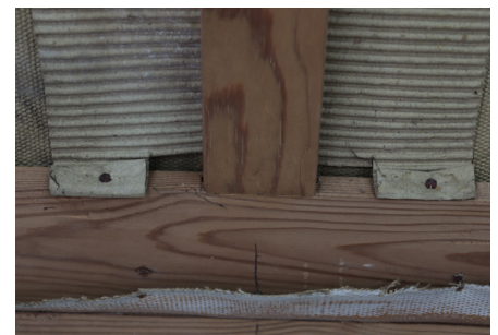
Figura 45.- Unión entre cartón corrugado y el bastidor
