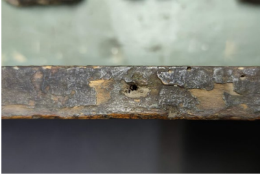
Fig. 33 Detalle de la pérdida de película pictórica
