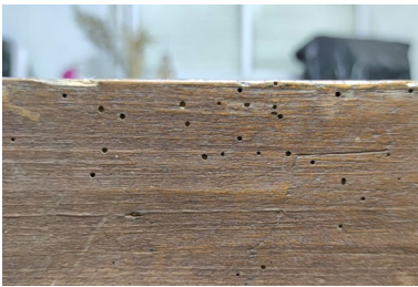
Fig. 31 Orificios de salida de insectos xilófagos
