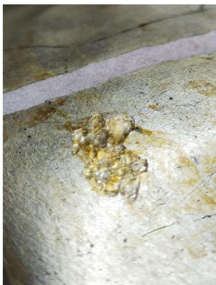
Imagen 118.- Aplicación del Gel Gelano en el reverso de la pieza.
