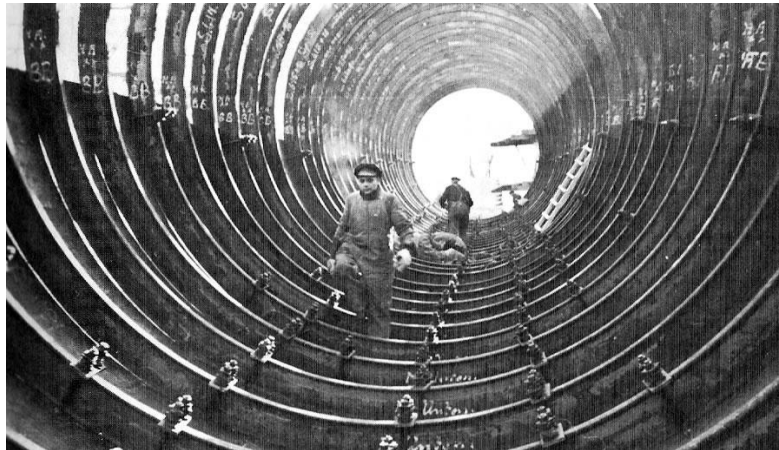
Figura 14. Cuadernas de un submarino. [23]
