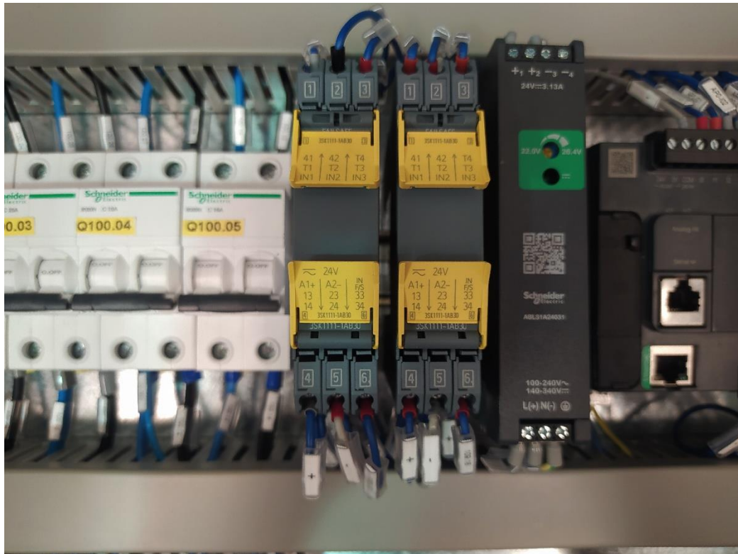
Img.12 Relés de seguridad con su esquema de conexiones
