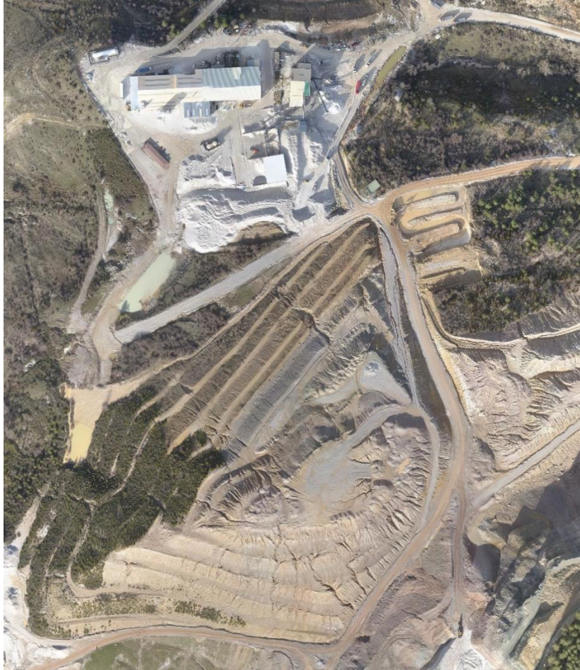
Ilustración 1. Imagen aérea de las instalaciones de CAOBAR SA en Poveda de la Sierra
