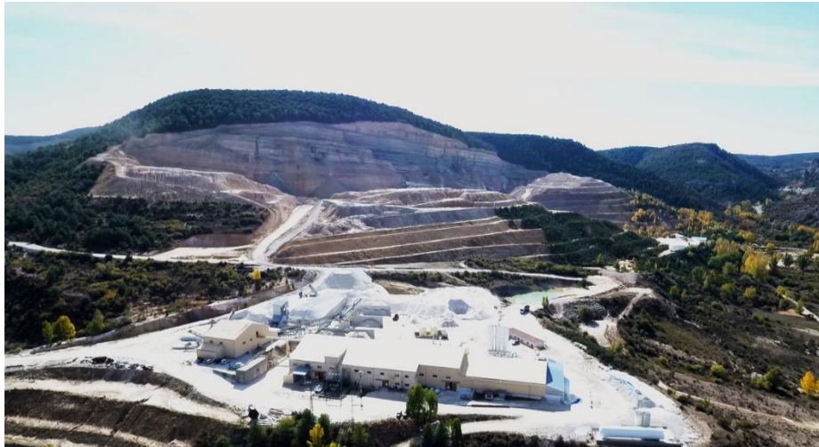
Ilustración 2. Foto tomada en la ubicación donde se llevaría a cabo la instalación
