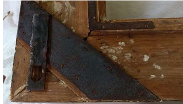
Figura 57 Detalle ensamble del marco
