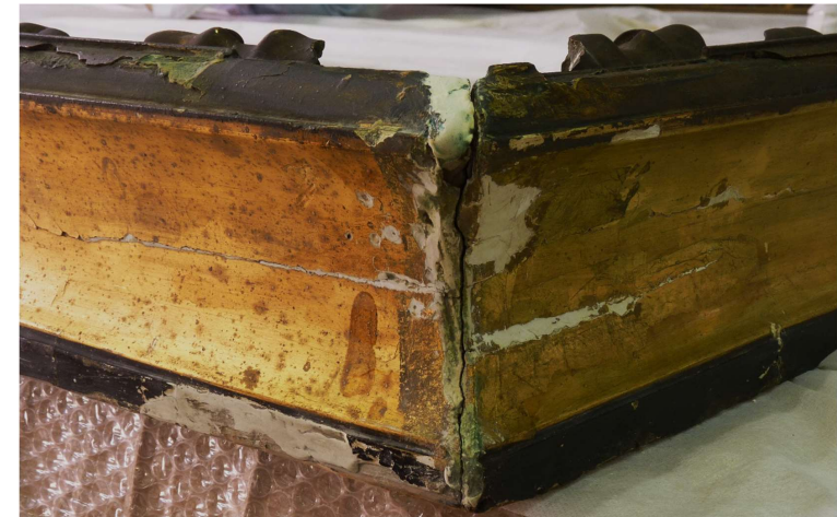
Figura 75 Detalle del ángulo del marco antes de ser intervenido
