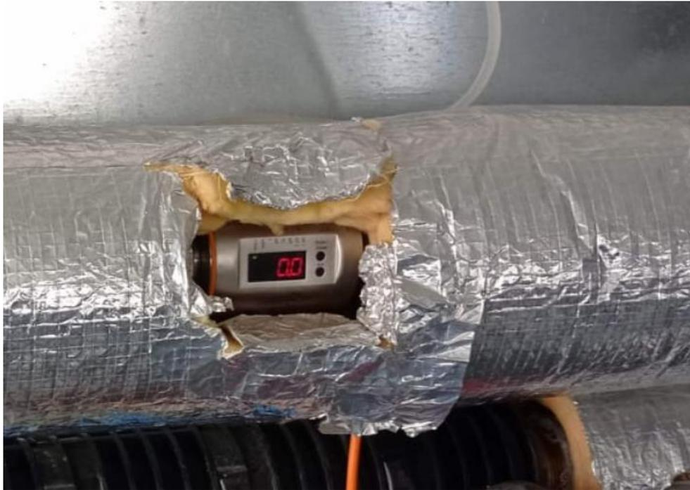
*Figura 10: Pantalla para visualizar el valor de la temperatura.*
