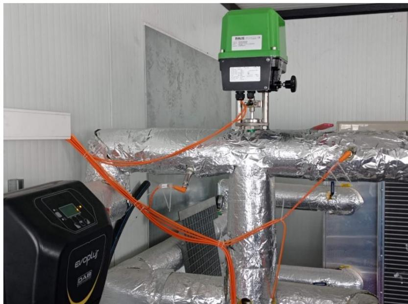
Figura 8: Válvula de 3 vías del sistema.
