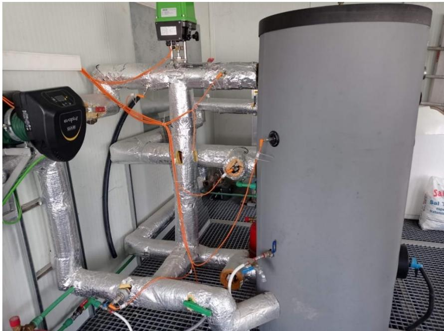
*Figura 9: Válvula de 3 vías en la instalación*
