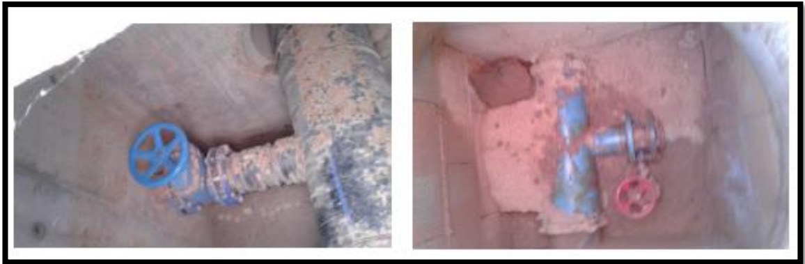
Figura 12: Detalle de anclajes en valvulería de desagüe.
