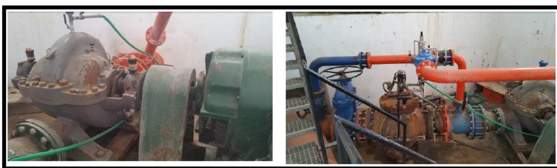
Figura 4: Estado de los equipos de Rebombeo Palmeral.
