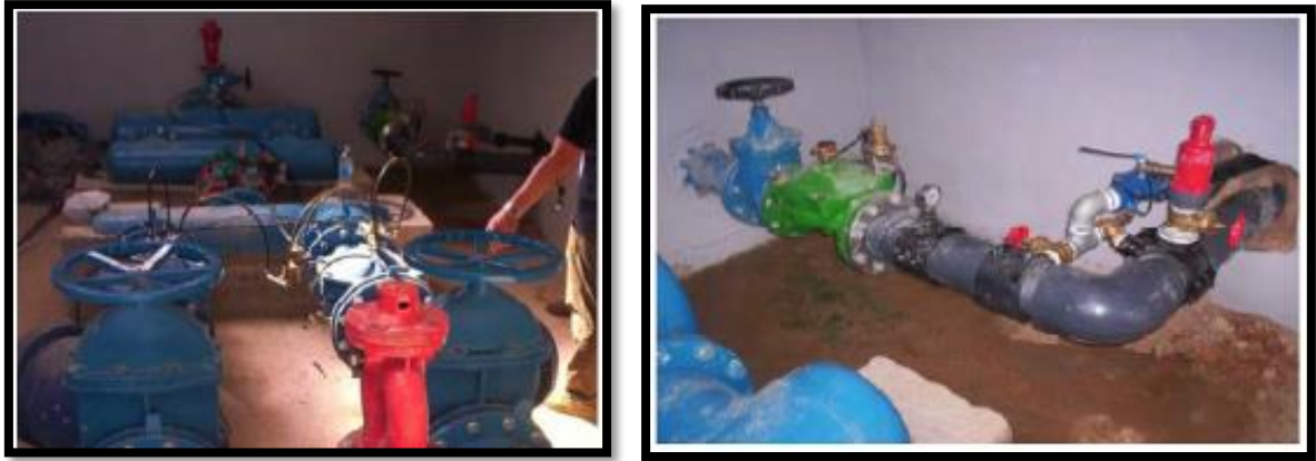
Figura 16: Detalle estaciones reductoras de presión.
