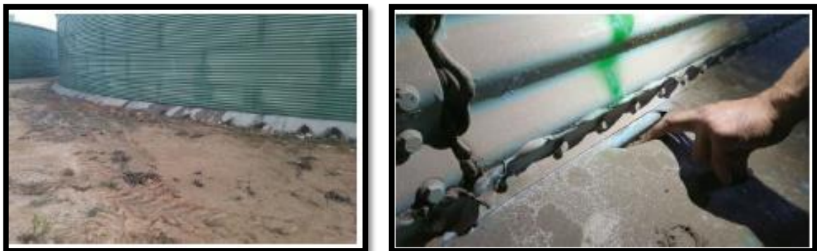
Figura 6: Fugas en Depósitos Gemelos.
