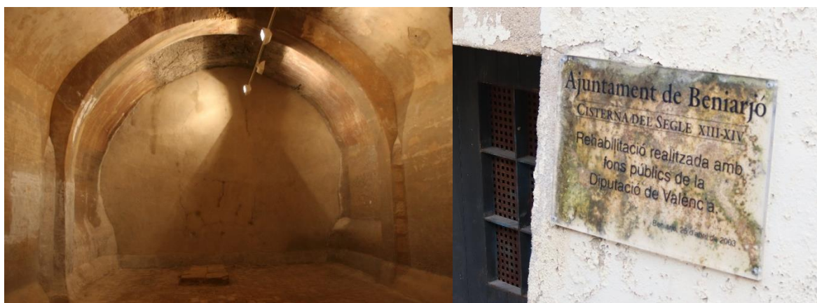
Figura 17. Cisterna y cartel de rehabilitación. Imagen de la izquierda extraída de la página web del ayuntamiento. Imagen derecha elaboración propia.
