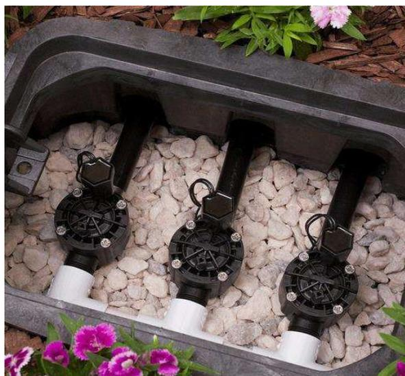
Imagen 18: Caja de Válvulas con tres válvulas con Solenoides
