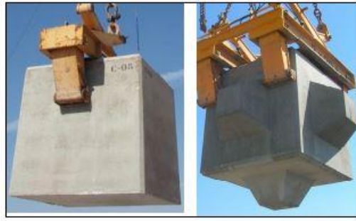
Fig. 17 Colocación de Cubípodos con pinzas de presión.
