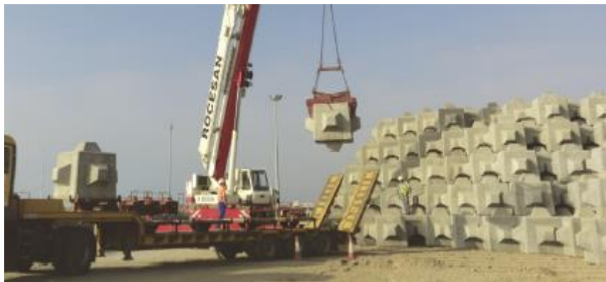
Fig. 108 Manipulación de Cubípodos en el parque de almacenamiento con pinzas de doble presión. Fuente: Web del Cubípodo.
