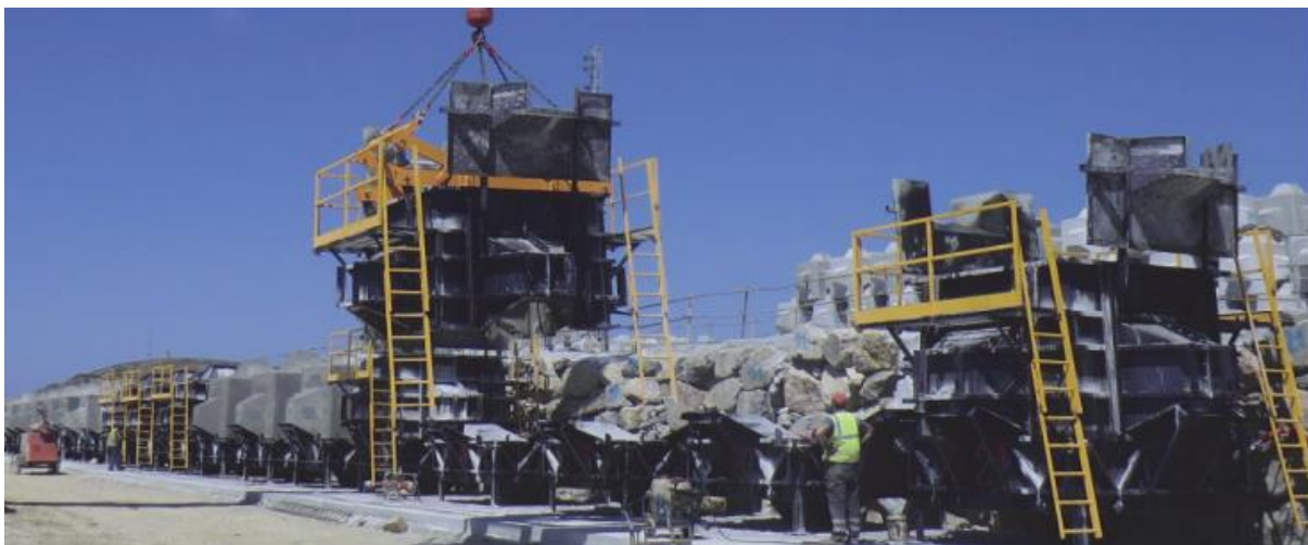
Fig. 104 Encofrados verticales del Cubípedo. Fuente: El Manual del Cubípedo, 2015.
