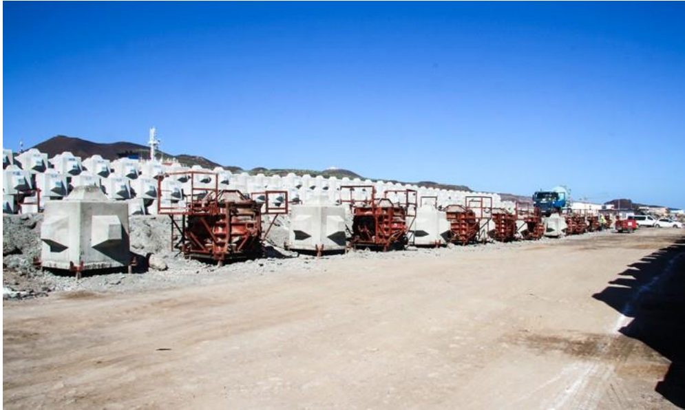
Fig. 105 Línea de fabricación de Cubípodos en el puerto de Málaga. Fuente: Web del Cubípodo.
