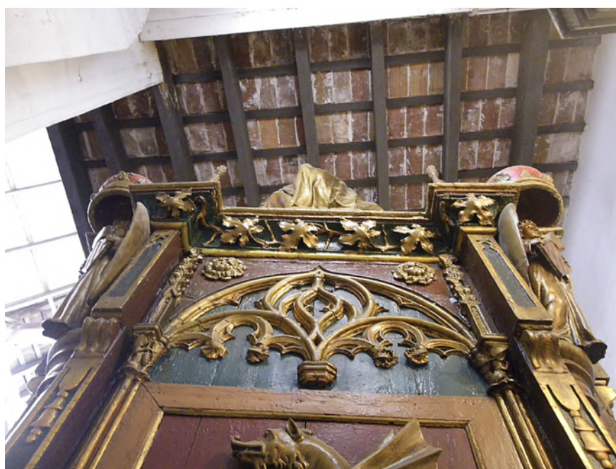
Fig. 10. Detalle de una de las tracerías de la roca "Valencia". Fotografía propia.
