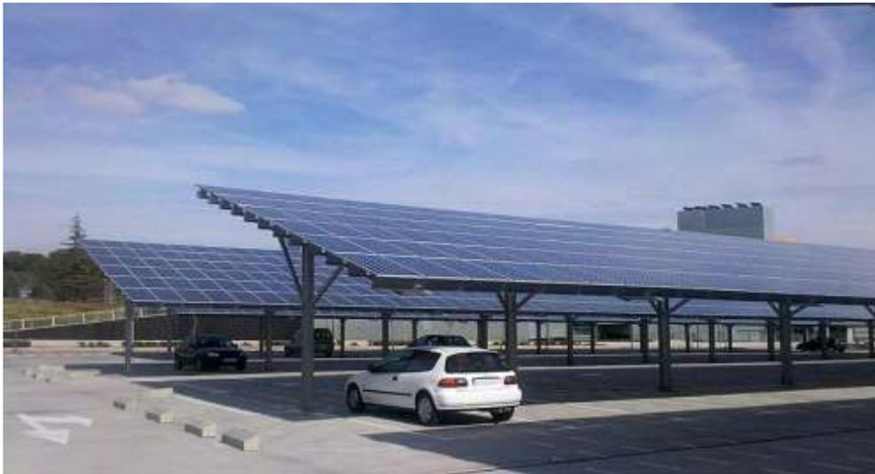
Figura 12: Ejemplo de integración arquitectónica. En este caso, se ha sustituido el techo del aparcamiento por paneles solares fotovoltaicos.
