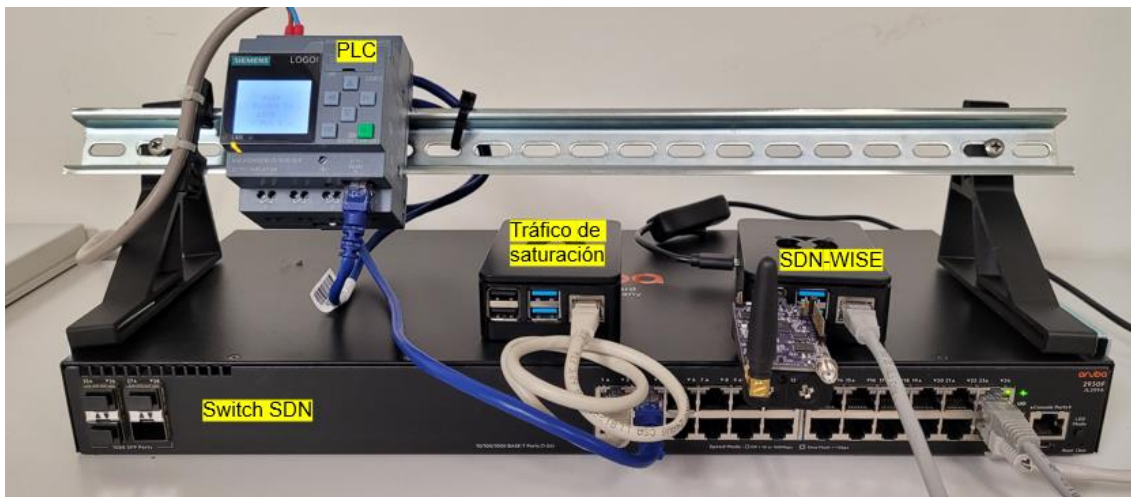
Figura 33. Conexiones del switch.
