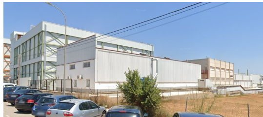
Figura 2: Nave colindante a la industria proyectada
