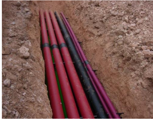
Imagen 33. Ejemplo zanja con tubo corrugados protectores. Fuente propia.
