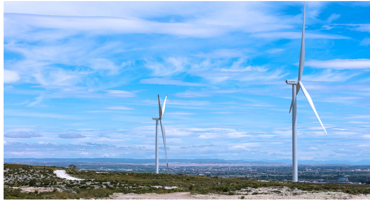
Figura 3.26: Instalación eólica terrestre (Fuente: Repsol).
