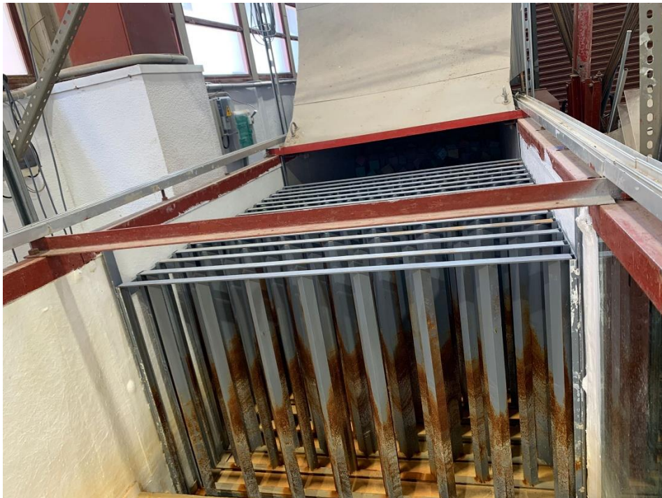
Figura 36: Sistema disipador de energía.
