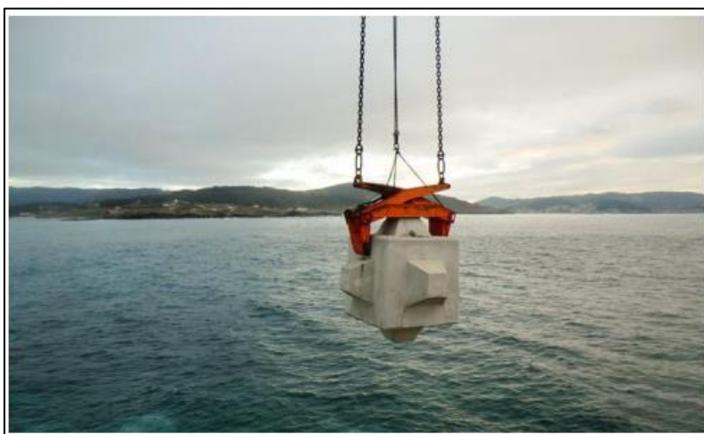
Figura 103: Colocación de Cubípedo en obra.
