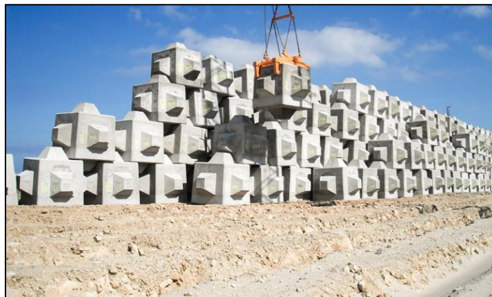
Figura 102: Acopio de Cubípodos.
