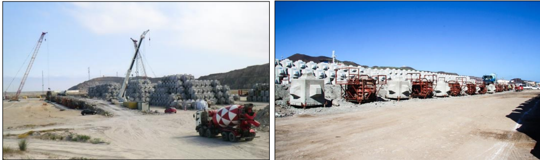
Figura 101: Hormigonado de los Cubípodos en obra.
