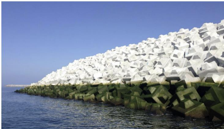
Figura 8: Contradique del Puerto Exterior de A Coruña (España)
