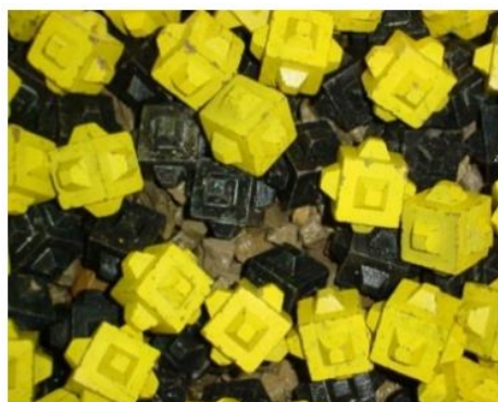
Figura 26: Ejemplo de ID en manto bicapa de Cubípodos.
