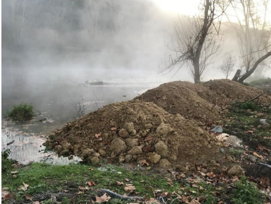
Figura 51. Cordones de sedimento en el punto de aporte de sedimento (fuente: Agència Catalana de l'Aigua, 2021).
