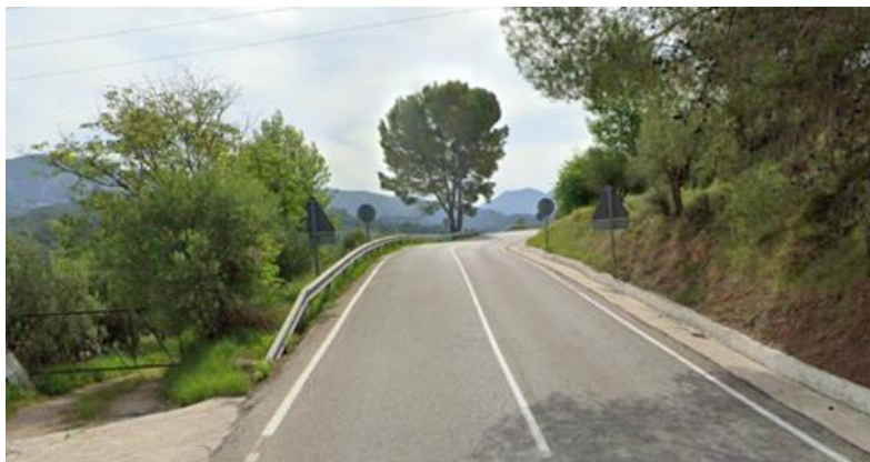
Imagen 8. Vista de drenaje longitudinal. Fuente: Google Earth.
