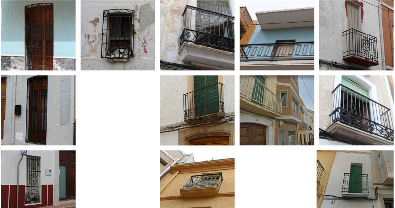
Figura 18: Comparació entre elements de la façana_1. Elaboració pròpia.
