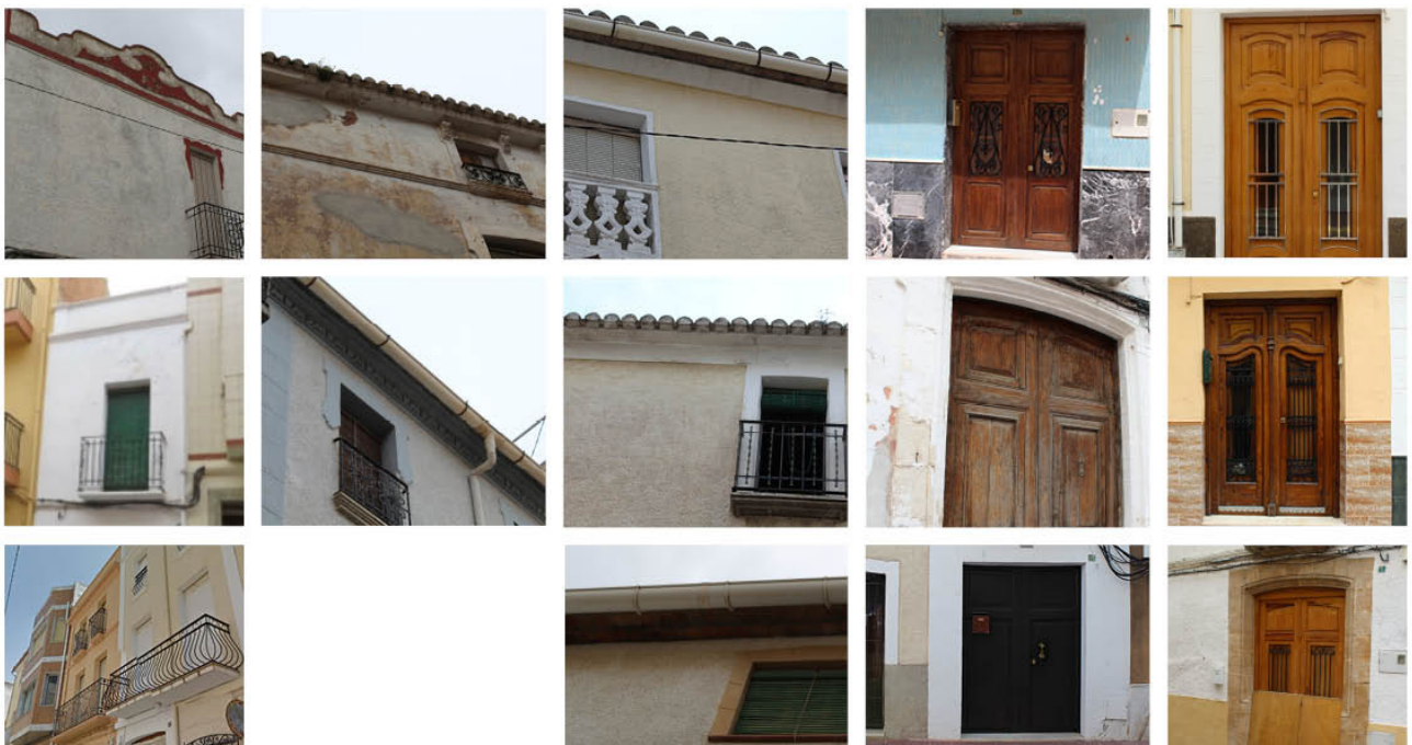
Figura 19: Comparació entre elements de la façana_2. Elaboració pròpia.
