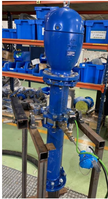
Figura 4.21. Ejemplo del montaje de las ventosas
