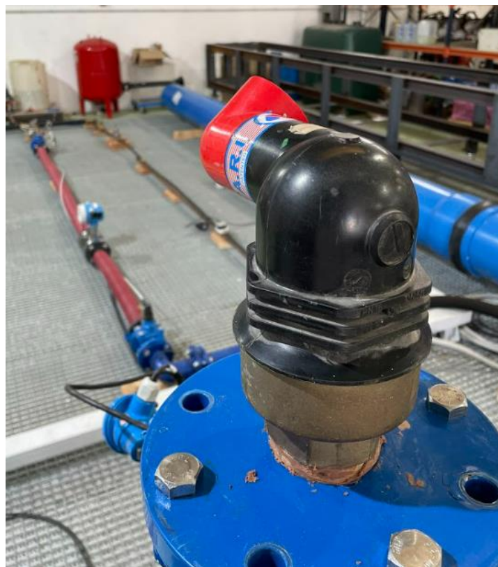
Figura 4.20. Banco de ensayo mientras se realiza el ensayo de la ventosa ARI D-040-NS
