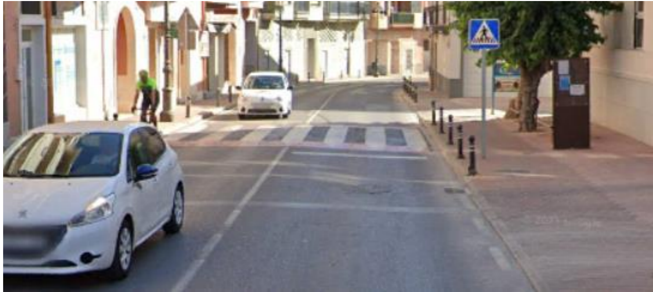
Imagen 23: Badén en la Calle Gabriel Miró. Fuente: Elaboración propia.
