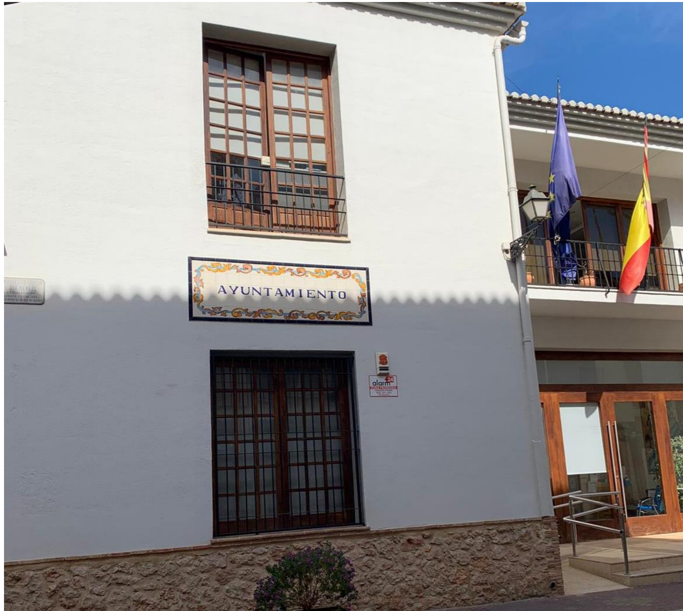
Imagen 7: Ayuntamiento de Polop. Fuente: Elaboración propia.
