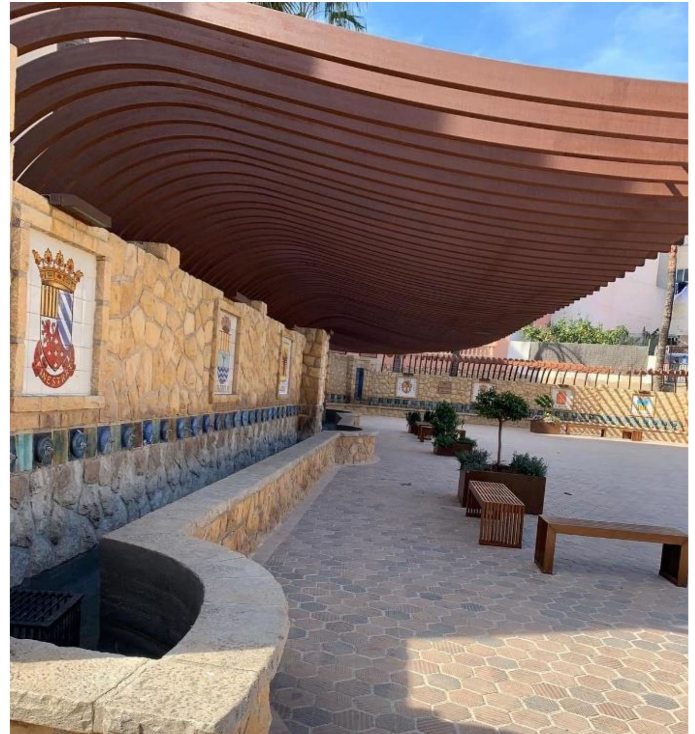
Imagen 13: Plaza de los Chorros. Fuente: Elaboración propia.
