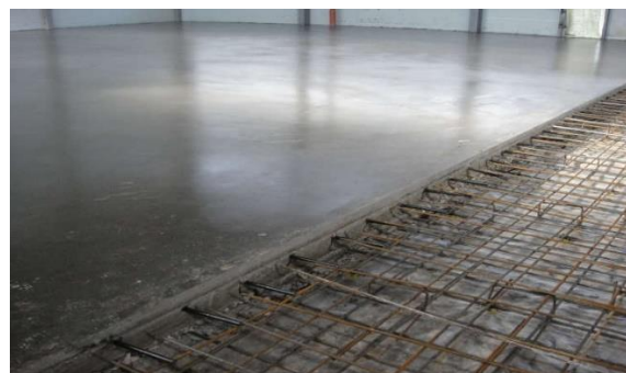
Figura 26: hormigón en masa solera
