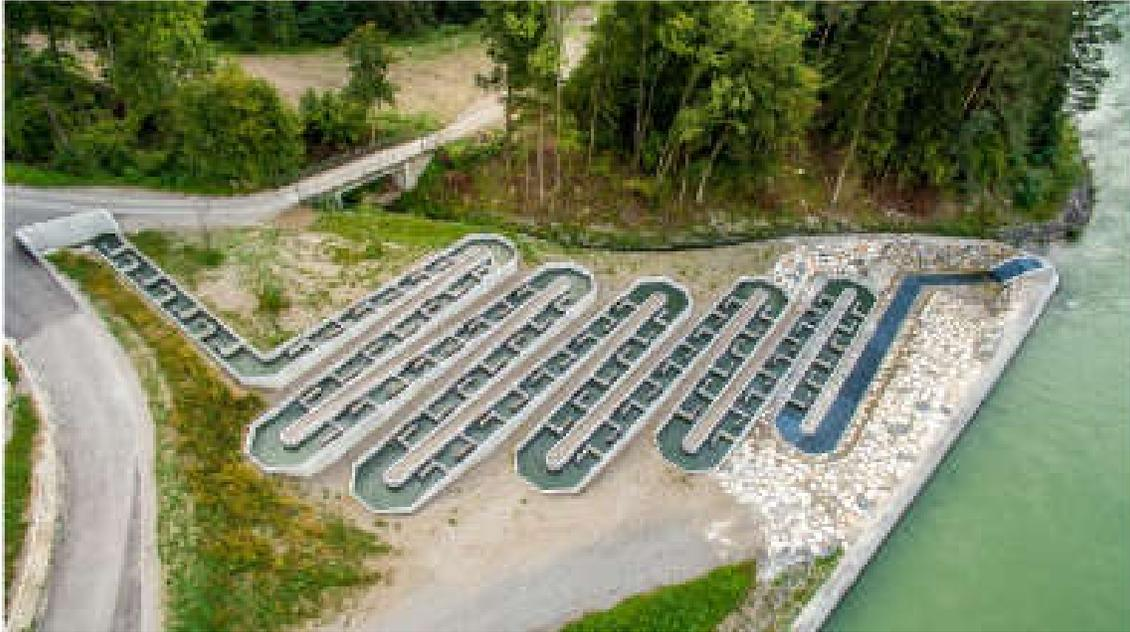
*Ilustración 3. Paso de peces en el Río Drava. (Fuente: Mader et al. 2020)*
