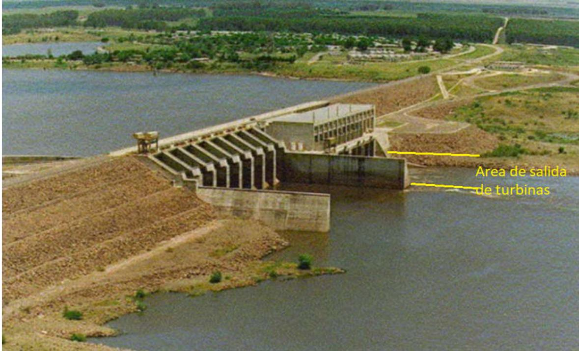
*Ilustración 26. Represa de Palmar con ubicación del área de las turbinas*
