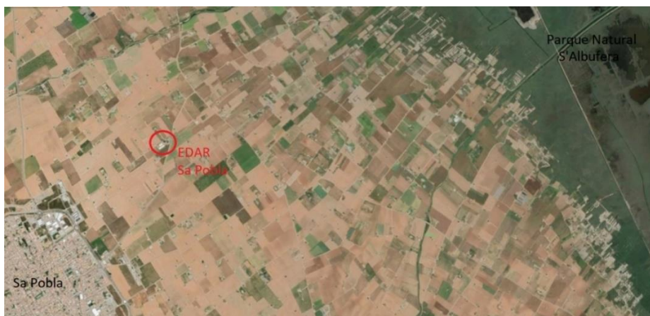
Figura 4. Localización de la EDAR Sa Pobra (FUENTE: Google Maps).
