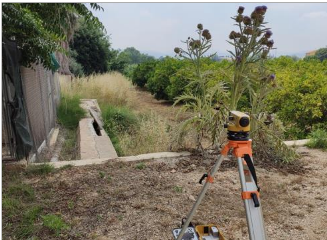
Foto 10 Obtención de cotas de zona de actuación mediante nivel óptico. La Pobla Llarga
