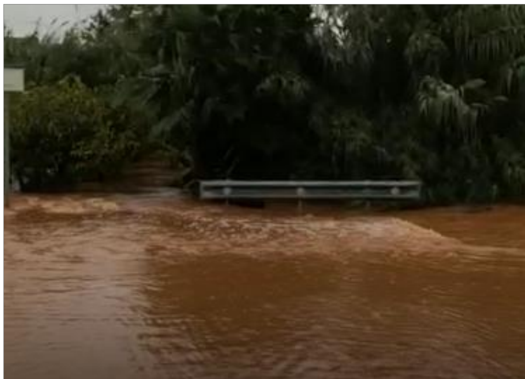
Foto 2 Barranco de Barxeta durante episodios de inundación, bajo la bionda se ubica el punto de desagüe de pluviales
