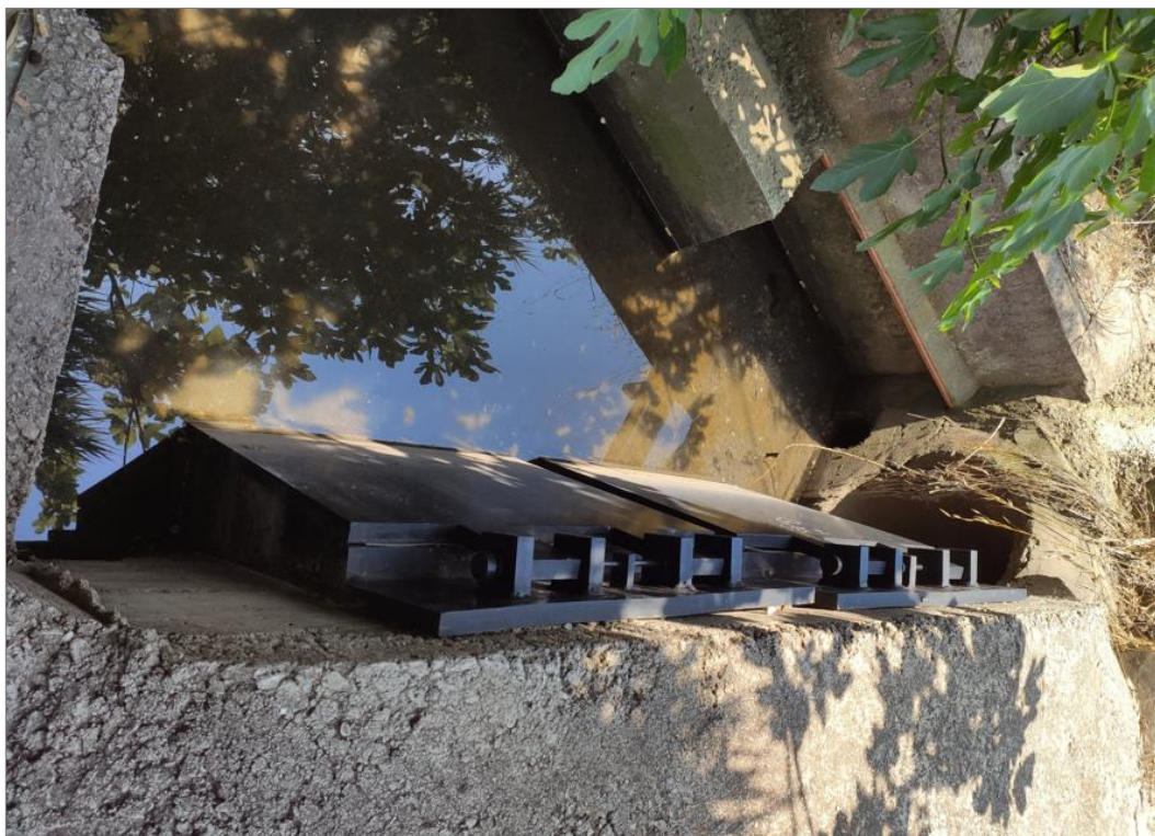
Foto 7 Punto de desagüe de pluviales en el cauce del barranco de Barxeta. Red alcantarillado La Pobla Llarga
