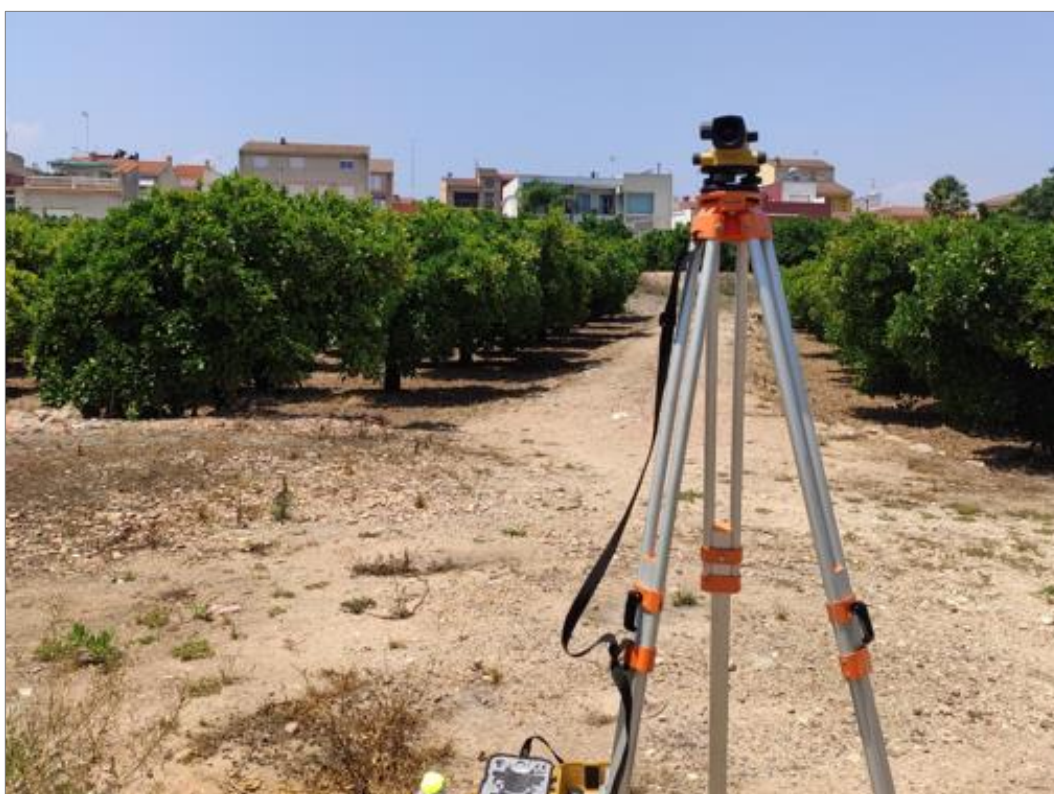
Foto 12 Obtención de cotas de zona de actuación mediante nivel óptico. La Pobra Llarga
