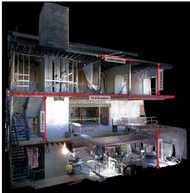
Ilustración 10 Vista proyecto en fase ejecución a través de herramienta BKL 360. (LEICA, 2022)
