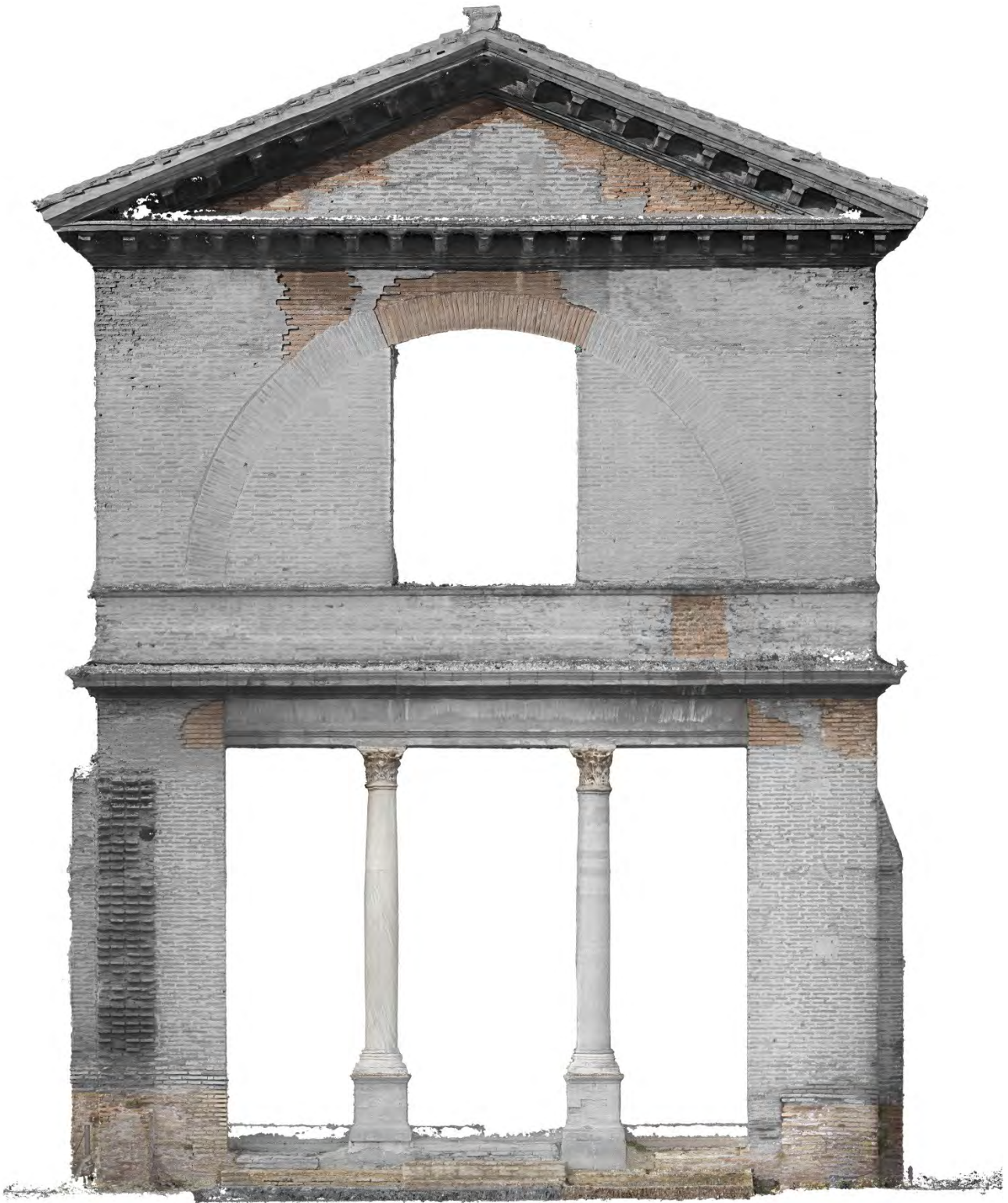
Fig. 13 - El fotoplano reelaborado de la Tomba dei Valeri muestra la fachada ricamente construida y solo algunas pequeñas porciones del paramento de la pared original (Fuente: Autor).
