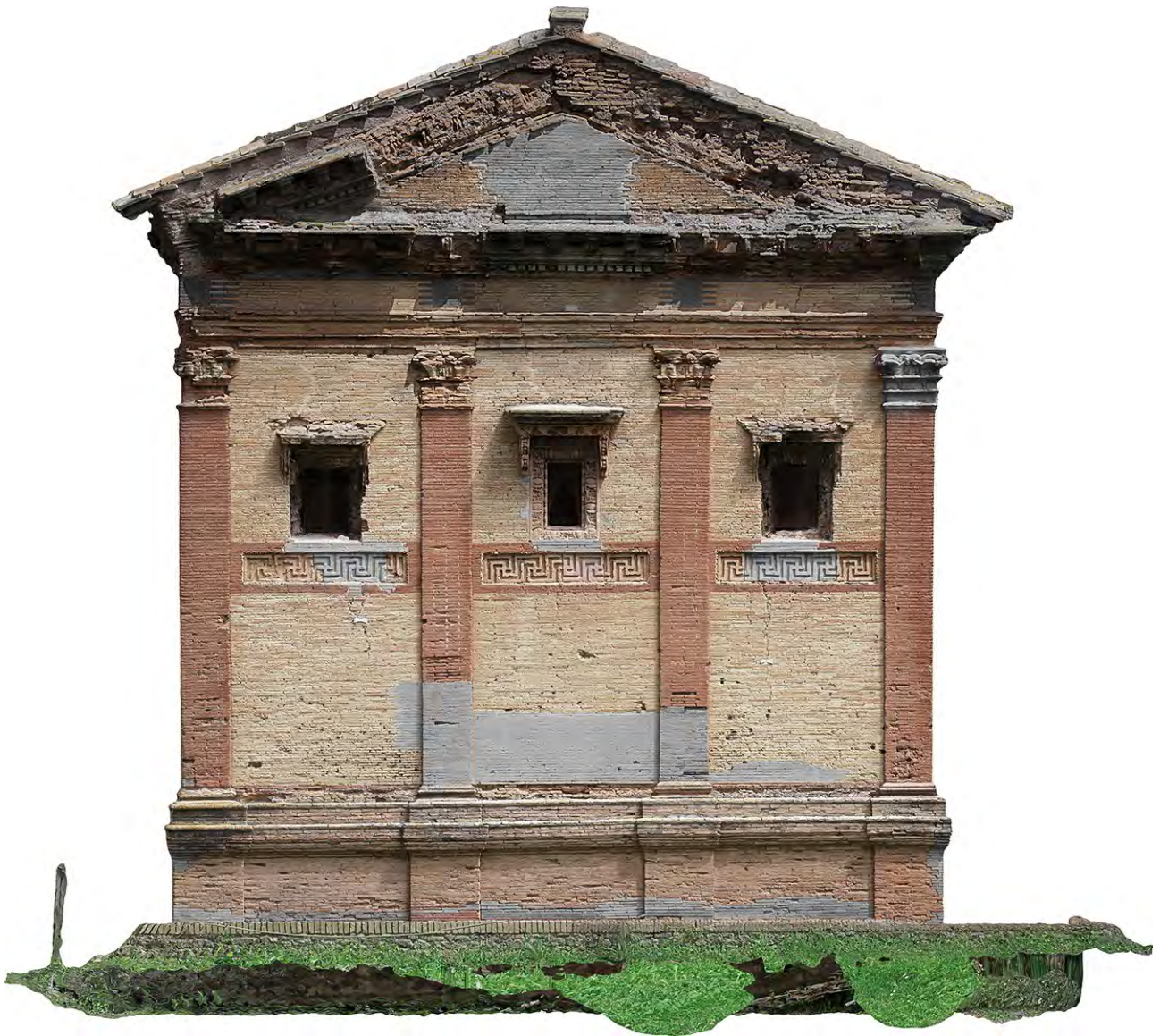
Fig. 12 - El fotoplano reelaborado en postproducción muestra las partes de la fachada reconstruidas durante las restauraciones que se han realizado a lo largo de los años (Fuente: Autor).
