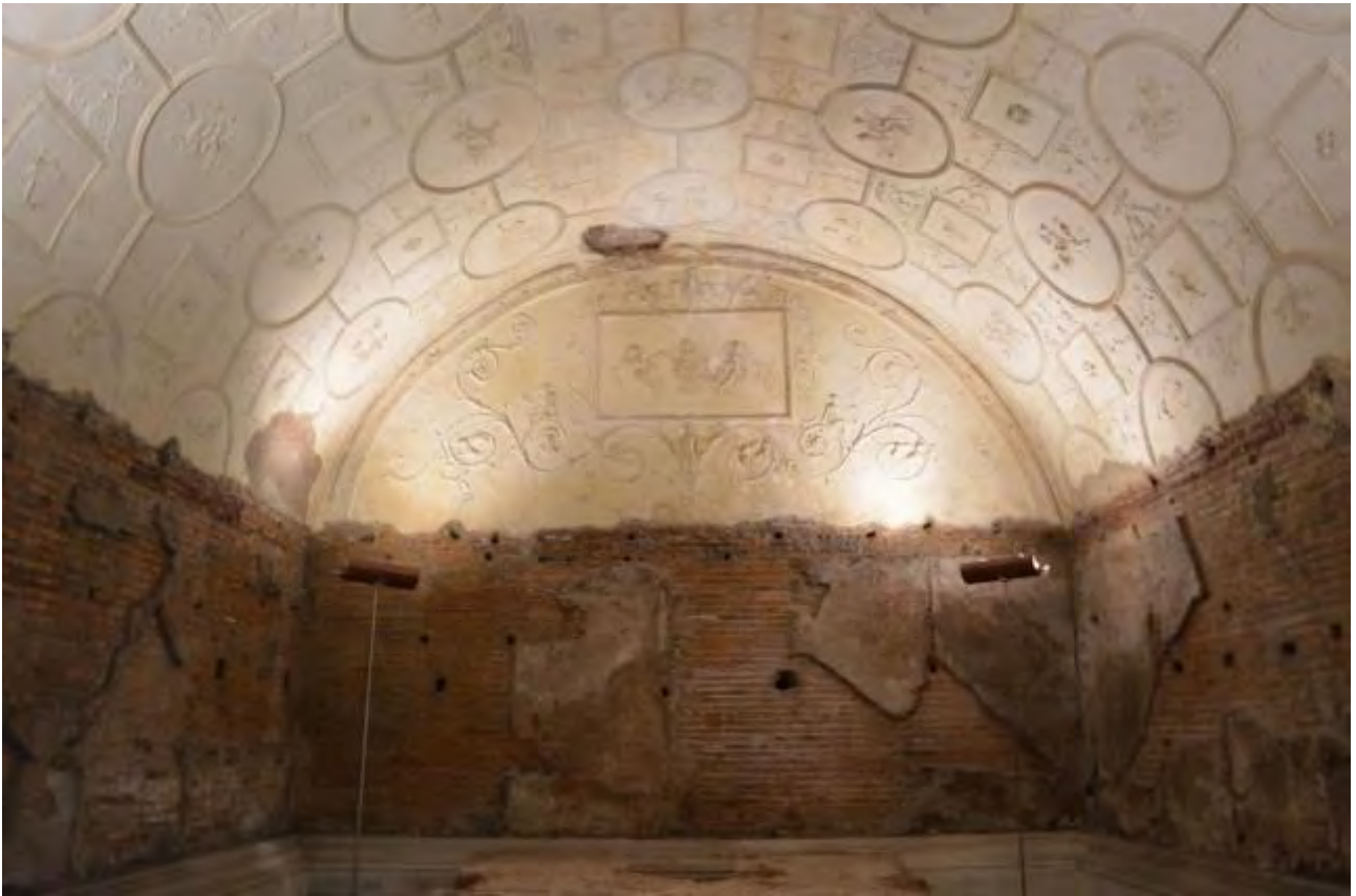
Fig. 46 - Sepulcro dei Valeri : cubierta abovedada de la cámara sepulcral principal decorada con estuco blanco con motivos dionisiacos (Fuente: Autor).
