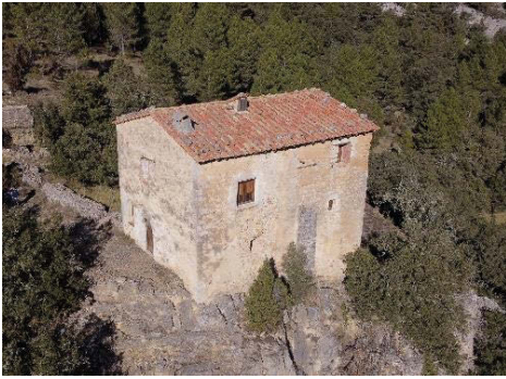
Fig. 5. Torre de Font d'en Torres, Morella (Source: Villasante Claramonte, 2022)
