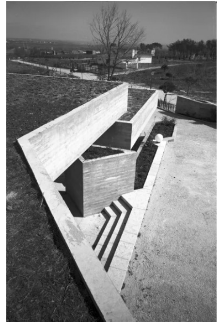
Fig. 60 Cubierta de la casa Carvajal. Fotógrafo: Paaco Gómez.
