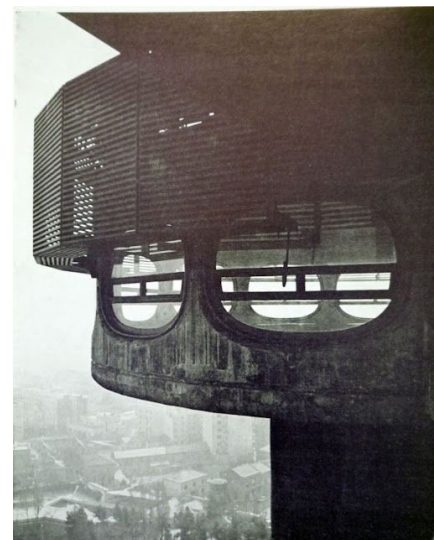
Fig. 95 Terminación del edificio.
