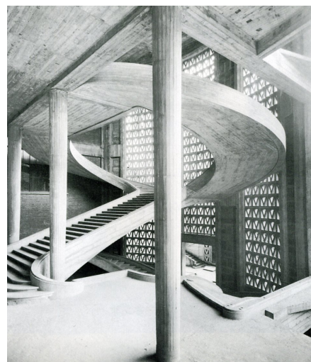
Fig. 09 Marcas del encofrado del Musée des Travaux Publics, París. Auguste Perret, 1936 - 1938
