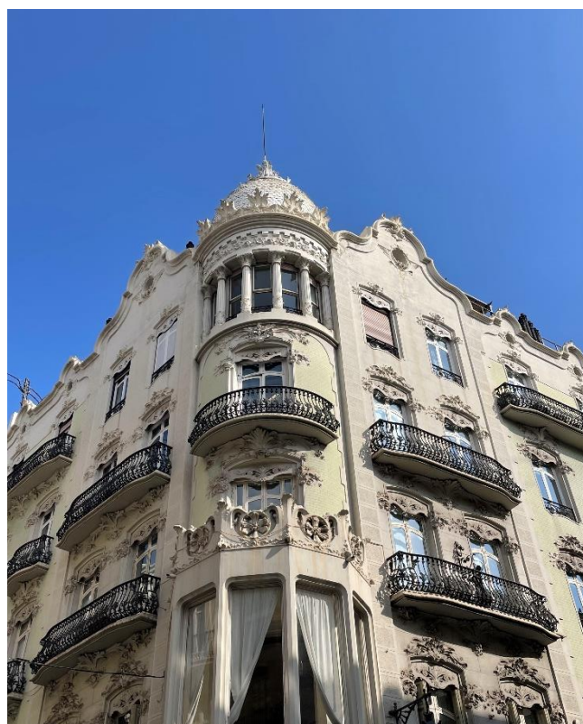
Ilustración 2 Edificio Gómez, Francisco Mora (1905), Fotografía de autoría propia.
