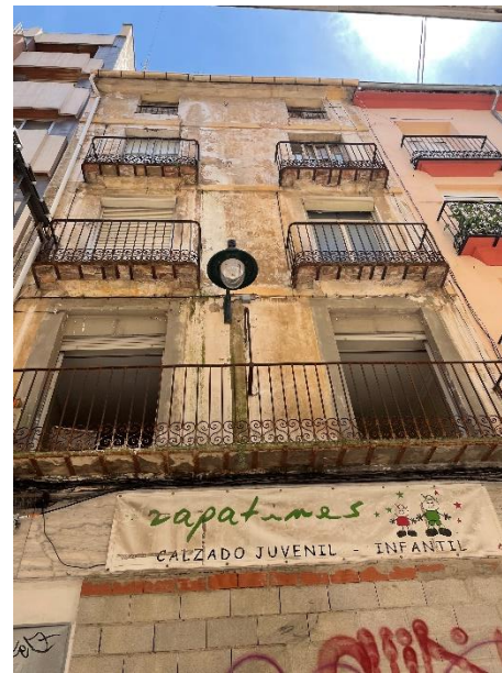
Il·lustració 5 Edificio en estado de conservación deficiente, C. Sant Francesc. Fotografía de autoría propia
