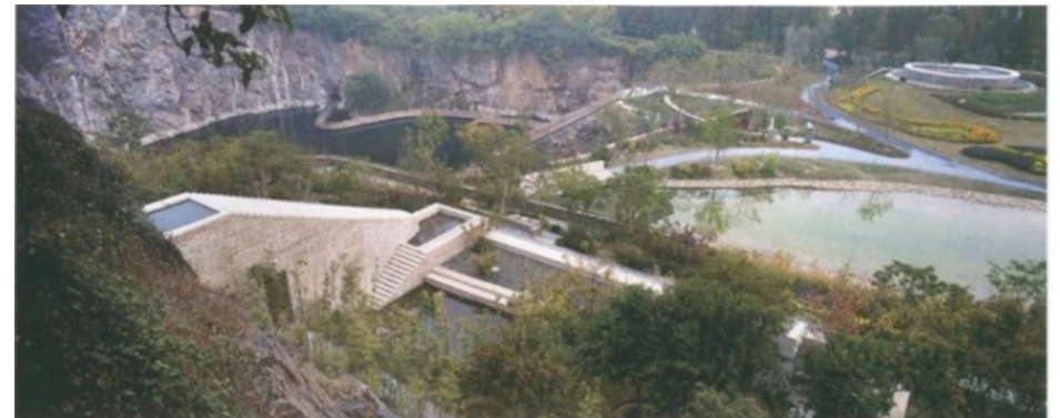
FIG 3.79. Con vistas a la piscina profunda de la mina.(Imagen extraída en red:baidu.cn)
