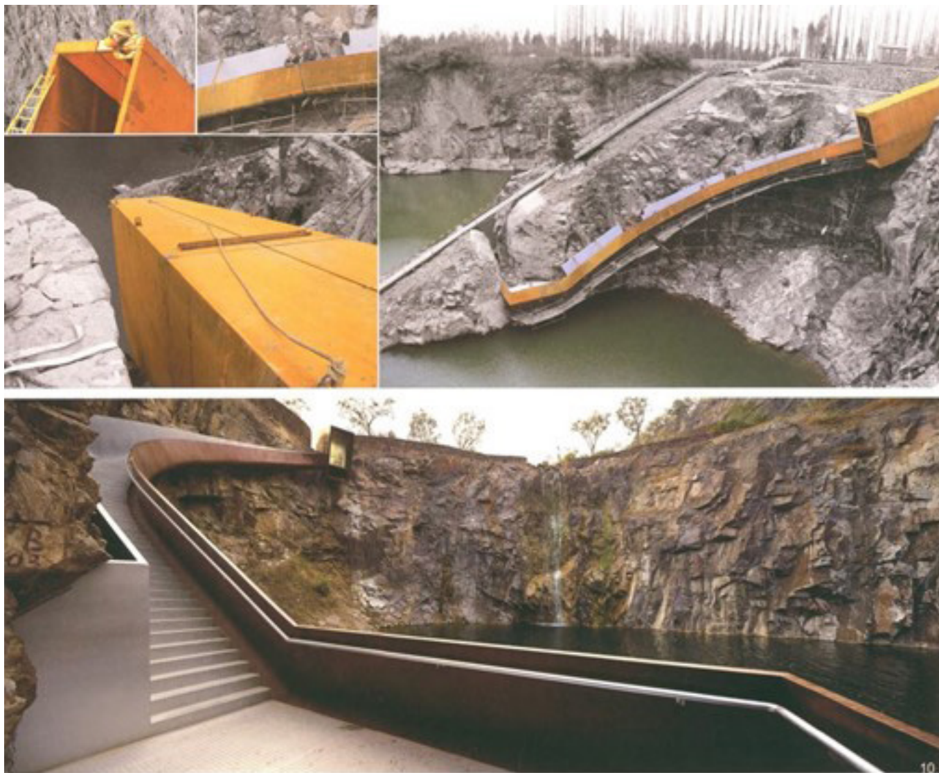
FIG 3.74. Proceso de construcción de carreteras de tablonés, Mirando hacia atrás al camino de tablonés en la plataforma "One Line Sky". (Imagen extraída en red:ikuku.cn)
