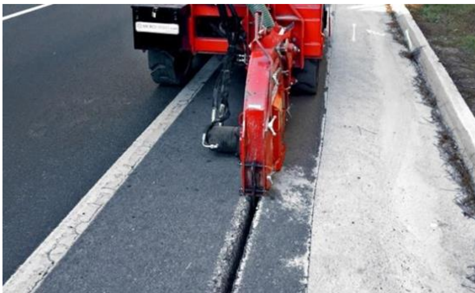
Figura 4: Corte de firmes asfálticos
