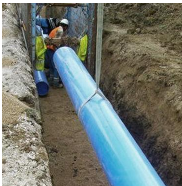
Figura 5: Instalación de tubería en zanja
